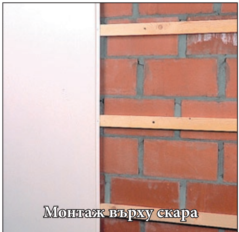
Монтаж върху скара чрез приковаване
