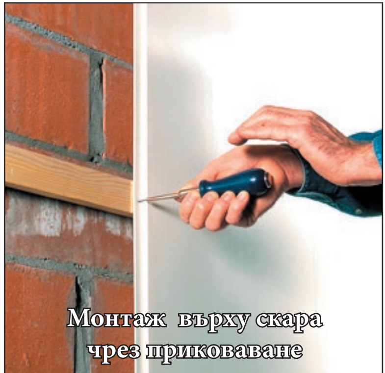
Монтаж върху скара с такер (телбод)
